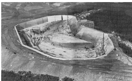
Fliegeraufnahme des Speicherbeckens (im Bau 1929)
