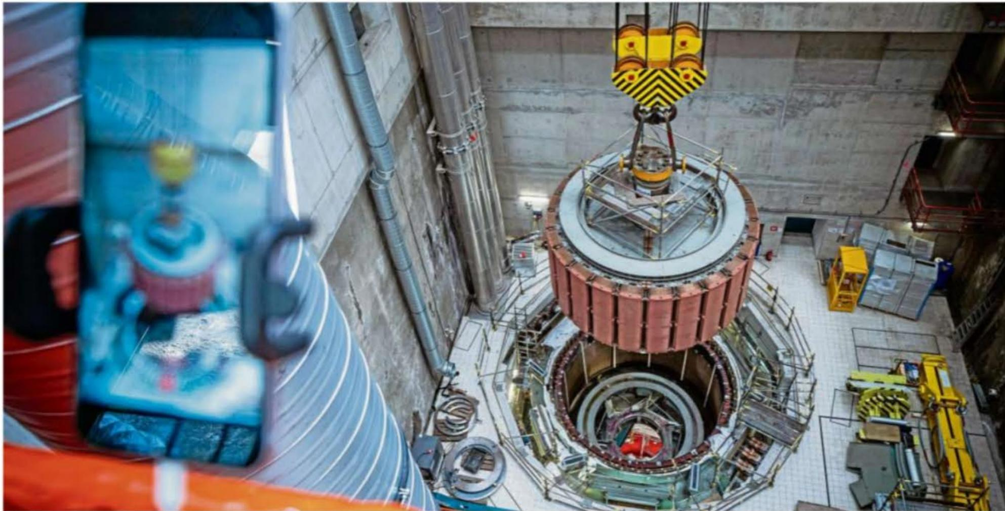
Im Pumpspeicherwerk Herdecke holen Spezialisten den 300 Tonnen schweren Generator aus dem Schacht nach oben. FOTOS: JAKOB STUDNAR / FUNKE FOTO SERVICES
